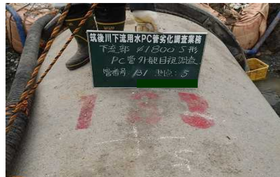
写真-2 管表面のマーキング状況
