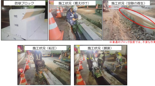
図-9 防草ブロック設置状況
