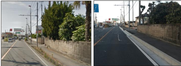
図-10 防草ブロック設置の実施結果
