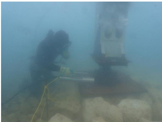
図-9 作業支援アタッチメント性能試験状況
