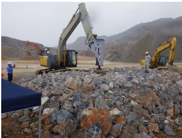
図-8 碎石場における陸上試験状況（沖縄名護市）
