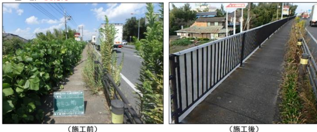
図-1 4 つるガード工法の実施結果
