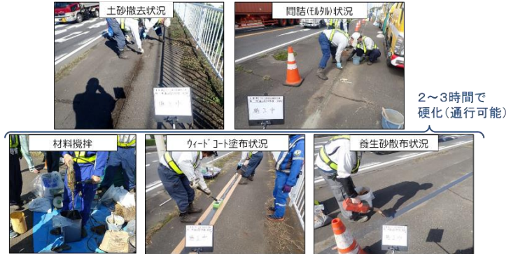
図-12 ウィードコート工法の施工状況
