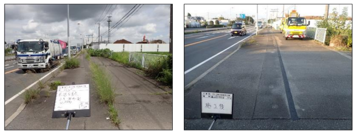
図-13 ウィードコート工法の実施結果
