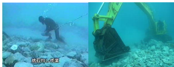
図-1 潜水士手作業（左）と水中バックホウ（右）
