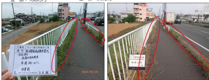
(施工前) (1週間後) 図-7 温水除草システム実施結果
