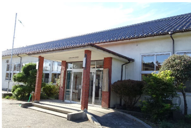
写真－2 旧庁舎（東側より）
