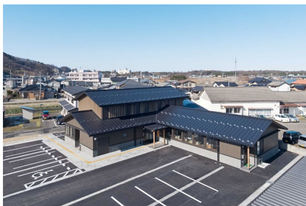
写真－1 新築庁舎（東側より）
