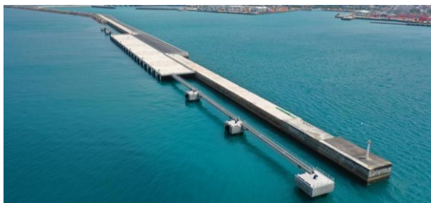
図-4 現状の岸壁部・係留部の外観
