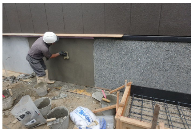
写真－4 豆砂利洗い出し仕上げの施工
