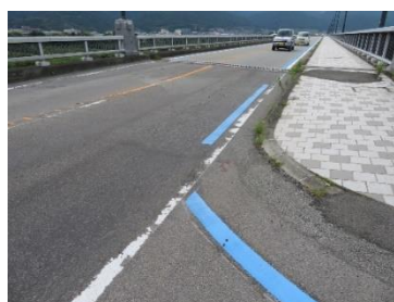
写真5 ブルーラインの設置状況
