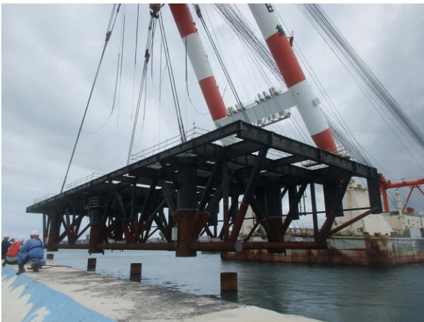
図-11 ジャケット据付工事の様子
