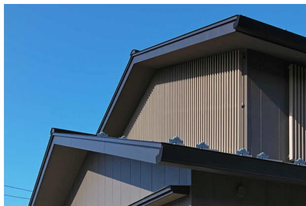
写真－5 勾配屋根と木製たて格子
