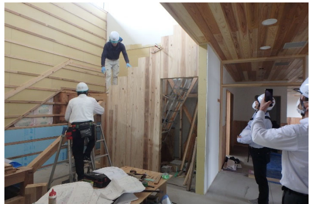
写真-10 CLT材の組立
