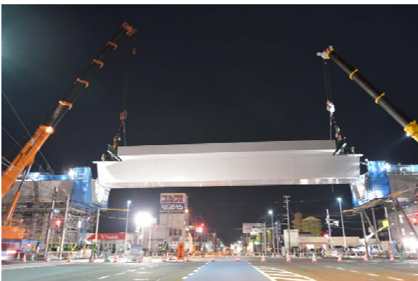
写真.1-3 交差点部での一括架設（H31.2）
