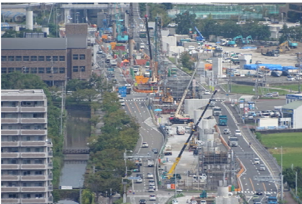
写真.1-2 橋脚工事（H30.9）の様子
