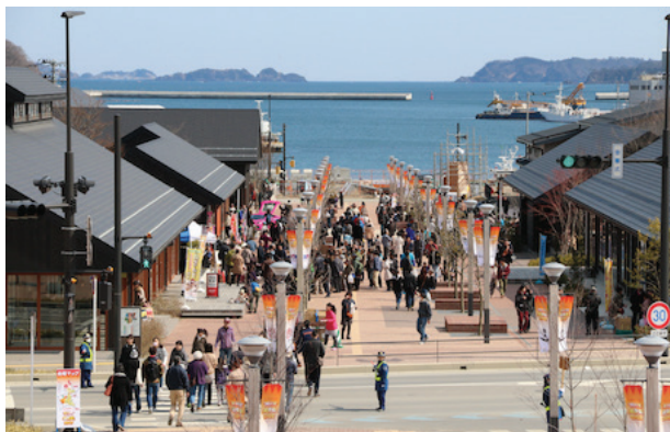
図4 女川駅前レンガみち周辺地区（写真提供：女川町）
