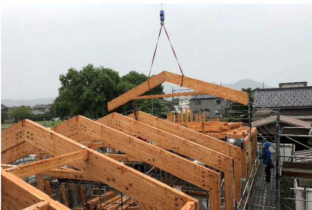
写真-11 集成材トラス梁の吊り上げ
