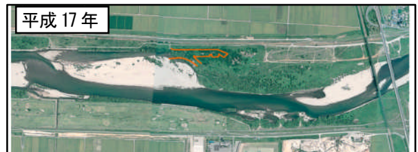
図8 平成23年施工予定箇所の過去と現在の状況
