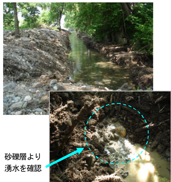
図9 試掘状況と湧水の湧出状況
