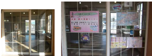
図7 情報提供施設出入口 改善前（左）と改善後（右）
