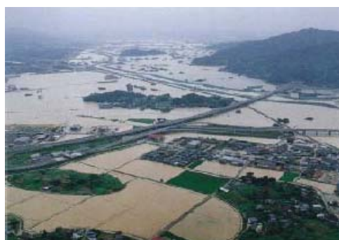
写真-1 武雄北方 IC 付近の浸水状況 (H2. 7)
