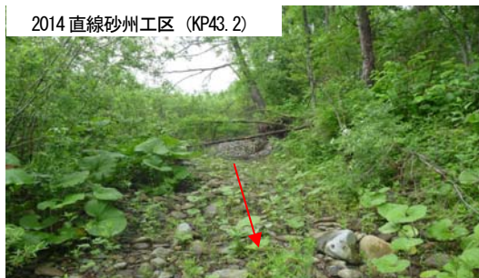
写真-3 放流前の旧川状況 (2014.6.10)
