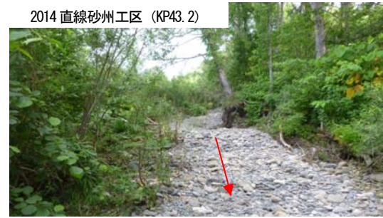
写真-4 放流後の旧川状況 (2014.7.7)
