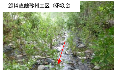
写真-7 台風11号出水前の旧川状況 (2014. 7. 7)
