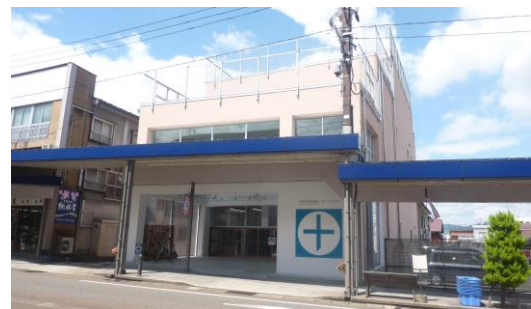
写真-13 施設の外観
