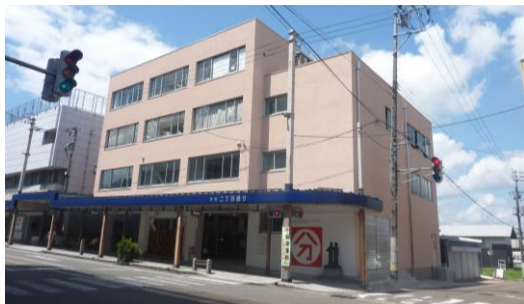
写真-11 施設の外観
