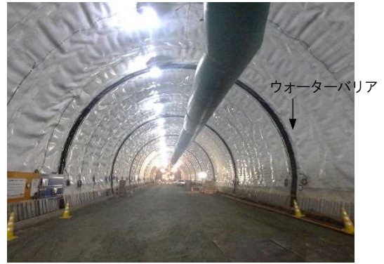
写真9 アーチ防水工完了全景
