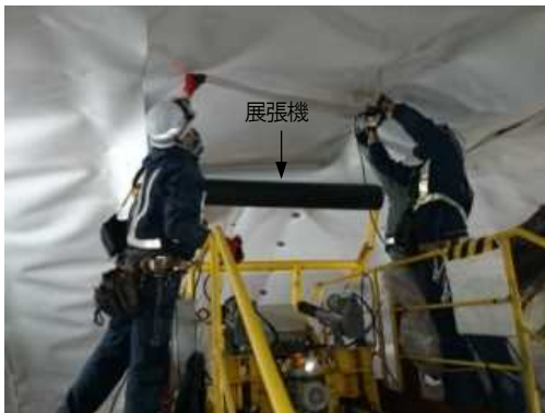
写真8 防水シート敷設状況
