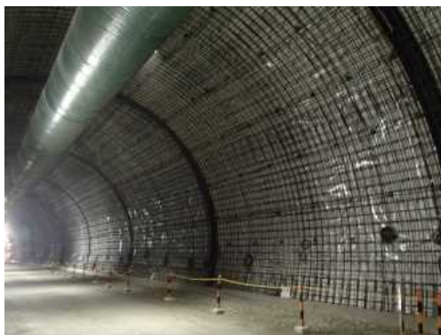
写真-14 アーチ鉄筋工完了全景
