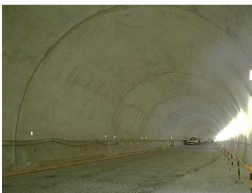
写真-16 アーチコンクリート工完了全景
