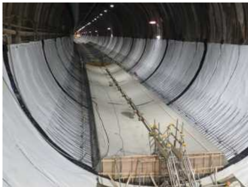
写真-2 インバート完了全景写真
