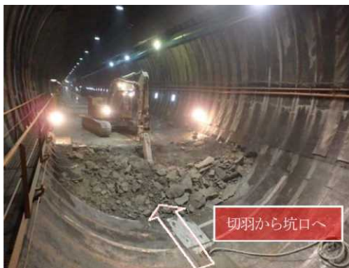
写真-1 インバート掘削状況写真
