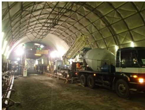
写真-15 アーチコンクリート打設状況
