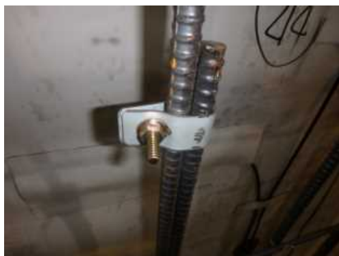
写真-13 鉄筋締結金具
