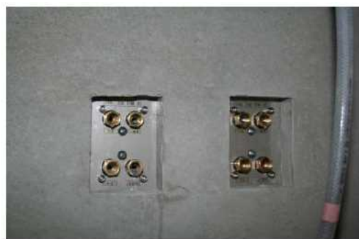
写真11 リペアシステム注入口
