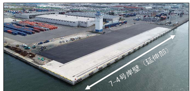
写真-1 完成した耐震強化岸壁
