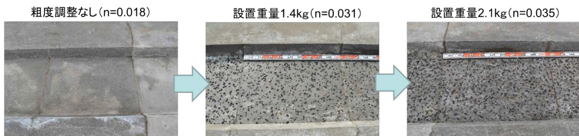
写真-6 粗度調整の様子
