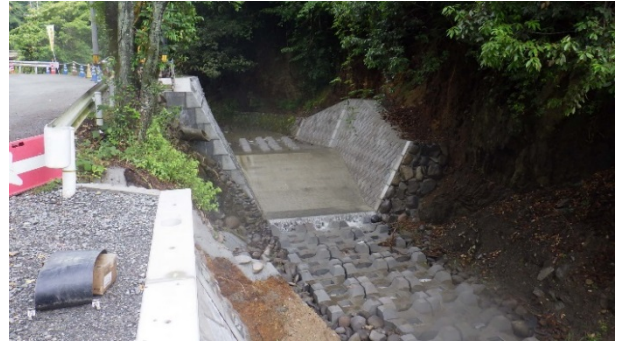
写真-1 原形復旧の様子
