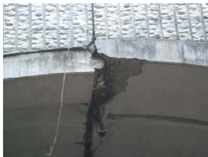
写真-3 ヒンジ部の損傷 (その2)
