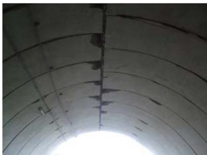
写真-2 ヒンジ部の損傷 (その1)
