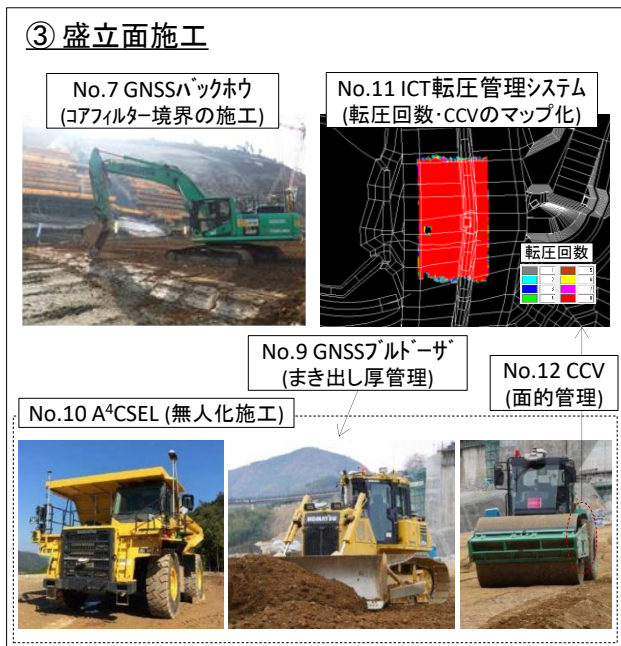
図-1 小石原川ダムにおけるICT施工の導入実績
