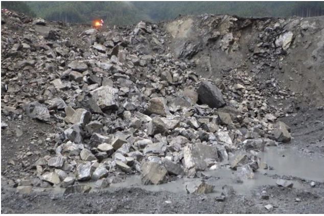
写真-2 発破後の切羽の外観（岩種判別が困難な例）
