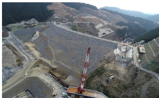
写真-1 小石原川ダム上流面 (盛立完了)
