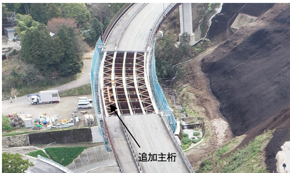
写真-3 追加主桁設置後のP2橋脚付近の航空撮影
