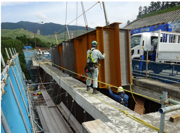
写真-2 追加主桁設置状況について
