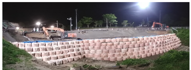
写真-3 7月9日 応急復旧状況(大型土のう設置)
