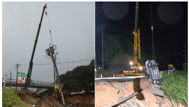
写真-2 7月6日 応急復旧状況(左 電柱移設, 右 車2台撤去)
