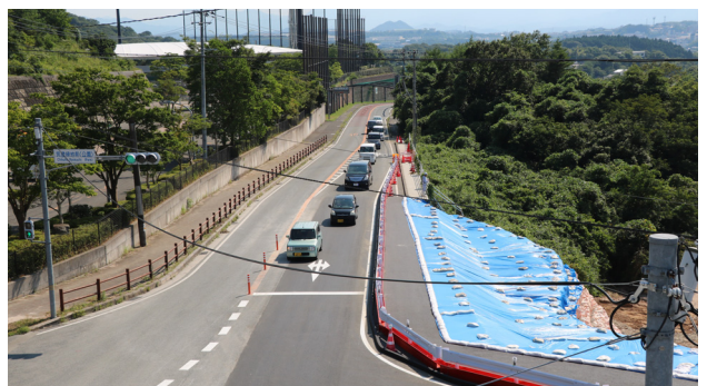
写真-4 7月12日 全面通行止め解除状況(福岡市方面を望む)
