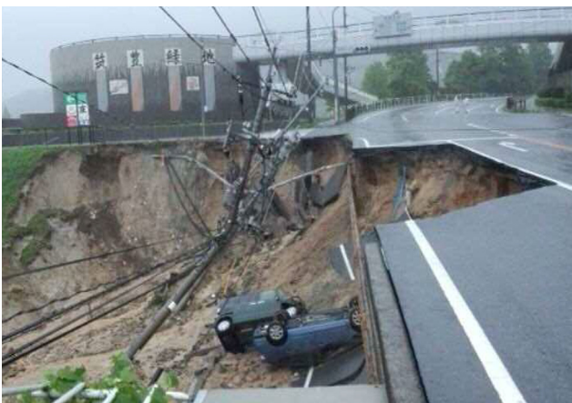
写真-1 被災状況(行橋市方面を望む)
