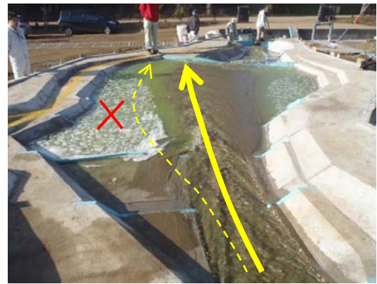
写真-6 洪水ピーク時における土砂堆積状況
