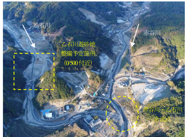
写真-3 乙石川遊砂地整備予定箇所(赤谷川・乙石川合流点)
