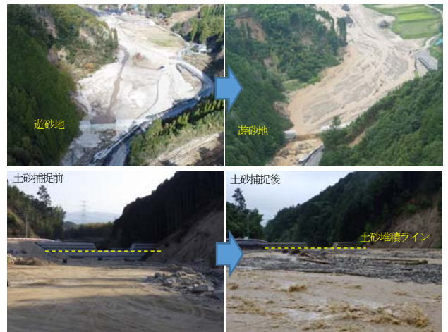
写真-4 乙石川遊砂地(応急対策施設)土砂捕捉状況 (平成30年:左上下,令和元年:右上下)
