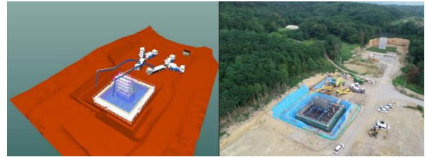
図-2 BIM/CIMモデルを活用した施工シミュレート
