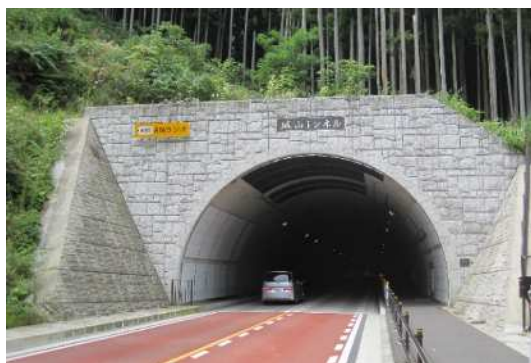
写真-2 城山工区（完成）
