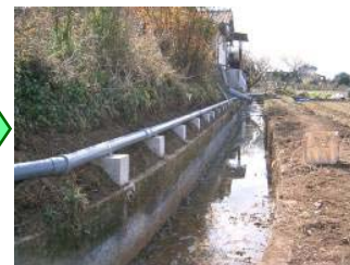
民地等を活用した露出配管により低コストを実現
