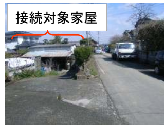
接続対象家屋 接道が家屋よりも高く、公道への埋設による従来の工法ではコストが割高となる
