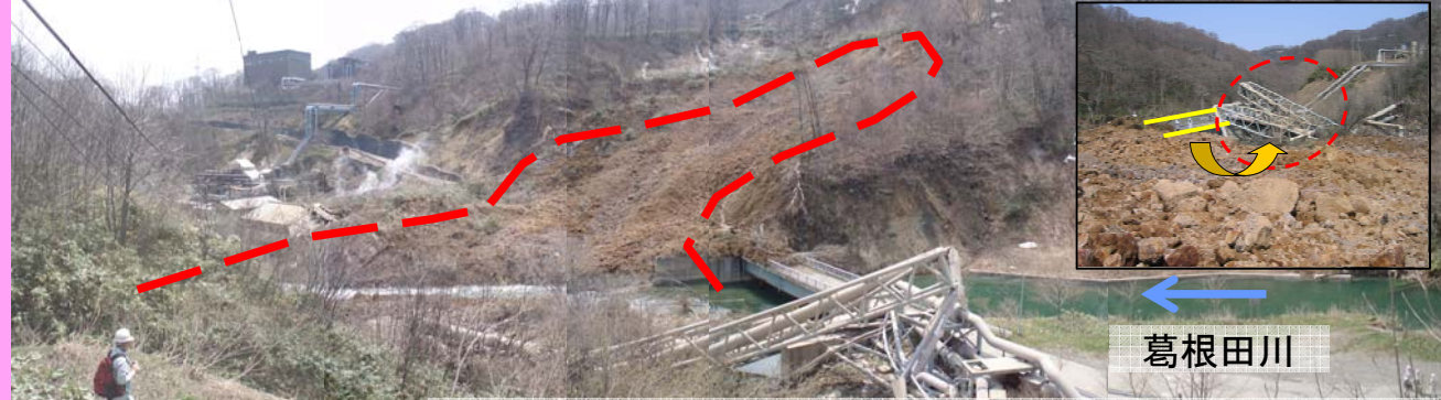
土砂の押出しにより歪曲した地熱発電施設の配管
