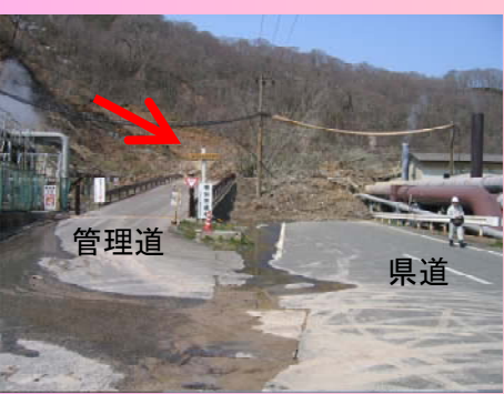
土砂の押出しにより歪曲した地熱発電施設の配管
