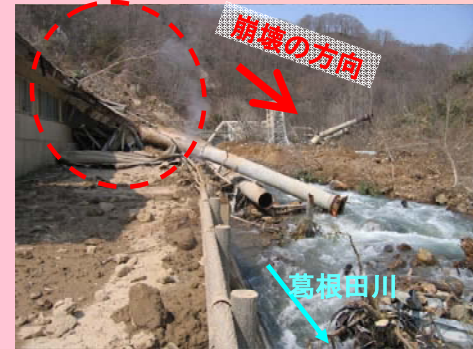
土砂の押出しにより歪曲した地熱発電施設の配管
