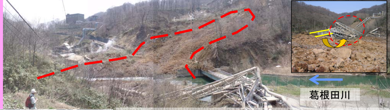
土砂の押出しにより歪曲した地熱発電施設の配管
