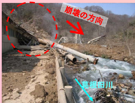
土砂の押出しにより歪曲した地熱発電施設の配管
