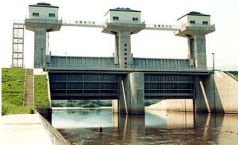
河川用ゲート設備
