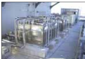
屋上 雑用水タンク
