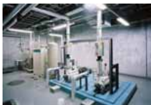
雑用水揚水ポンプ
