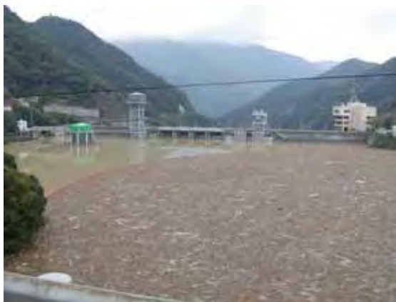
流木の流入によるダム機能の低下
