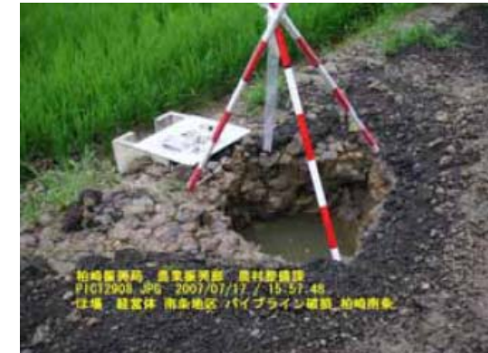
農業用水パイプラインの破損
