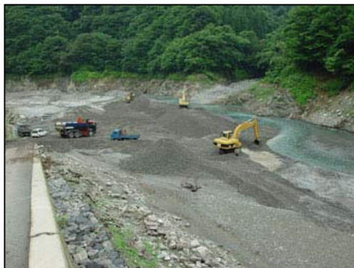
堆積した土砂の掘削運搬状況
