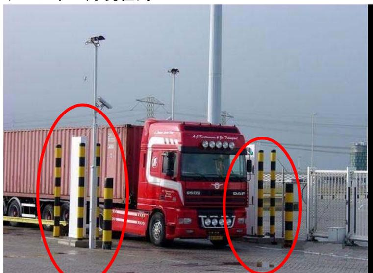
コンテナを載せたトラックが、○印の白いゲートを通過する際に、コンテナ内の放射性物質の有無を検知する。
