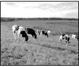
【堤防法面を放牧地として活用】堤防(丘陵堤)法面の放牧地・採草地としての有効活用を検討するため、放牧実験、牧草生育実験とともに堤防管理上の安全性確認調査等を実施中
