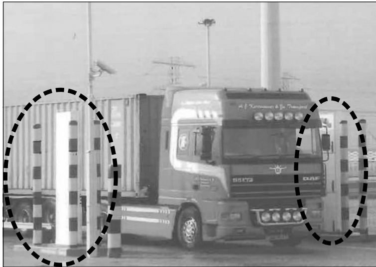
【放射性物質検知施設 (蘭・ロッテルダム港の例)】
