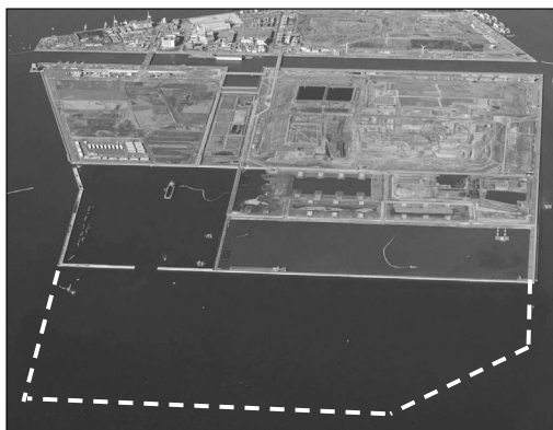
【東京港 海面処分場】
