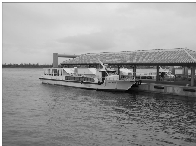
【手すり、スロープ等が整備され、バリアフリー化されている石垣港旅客船ターミナル】
