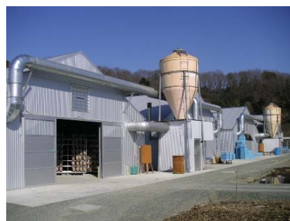
しいたけ栽培施設のボイラー
