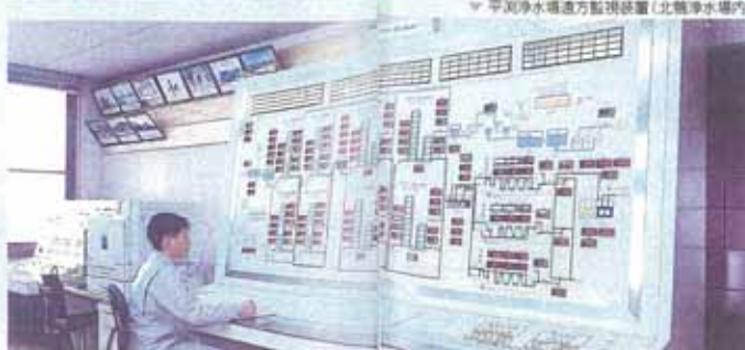
▼ 平潤浄水場遠方監視装置(北館浄水場内)
