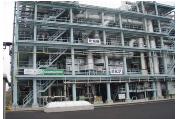
図2-3 汚泥炭化施設全景
