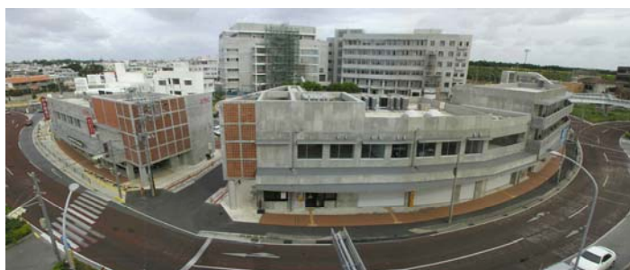
ロータリー地区全景（新町側より）
