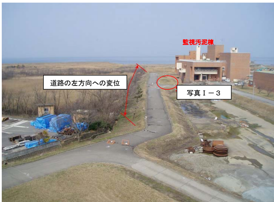
写真 I - 2 汚泥棟周辺地盤の変状
