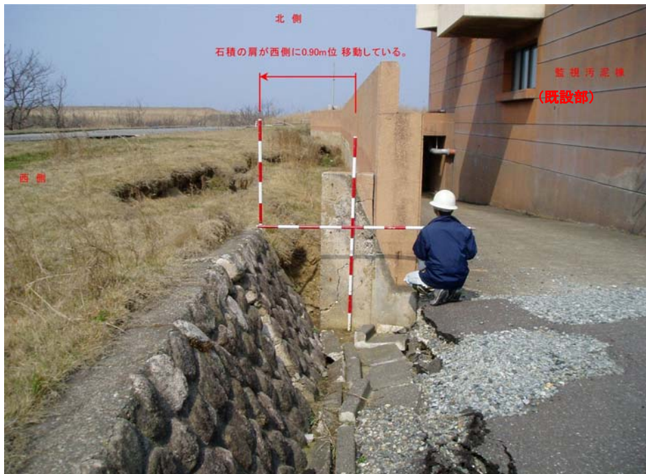
写真 I - 3 汚泥棟周辺地盤の変状
