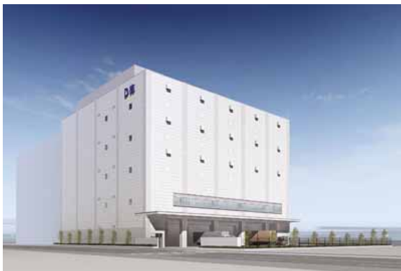
物流ビルD棟(平成17年7月竣工)
