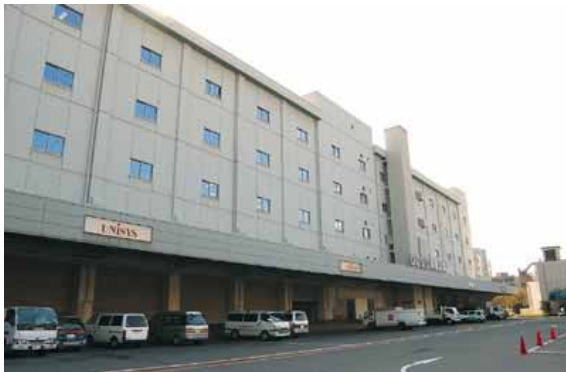
物流ビルC棟(昭和59年12月竣工)
