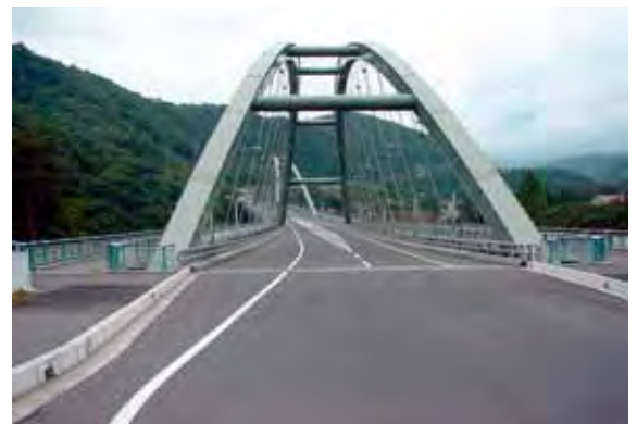
付替国道工事（長野原めがね橋）
