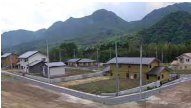
代替地関連工事（一本松地区）
