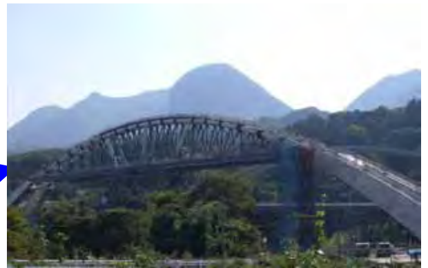
付替鉄道工事（第三吾妻川橋梁）
