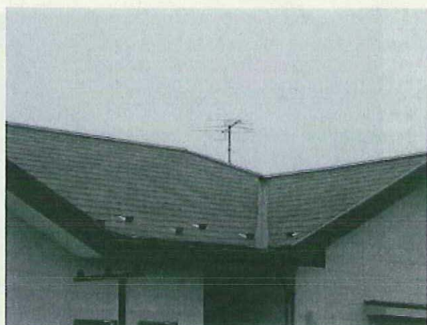
No.3 南西面屋根
