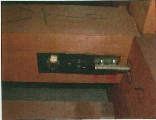
No.13 屋根裏 羽子板ボルト (ボルト止め)
