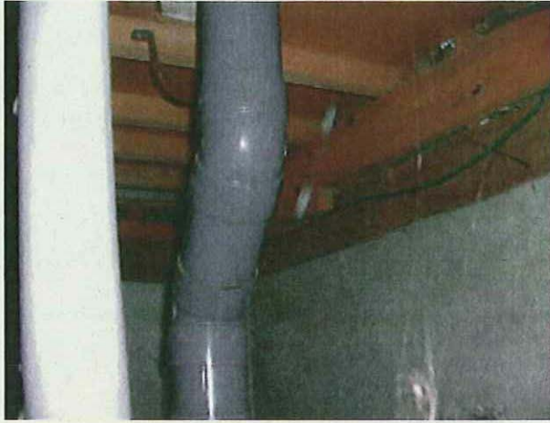
No.19 トイレ床下 排水管に異常は認められません。
