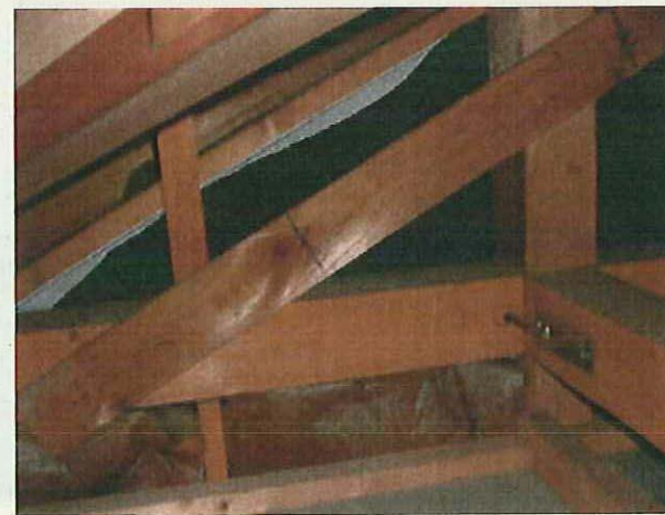
No.12 屋根裏 壁の断熱材
