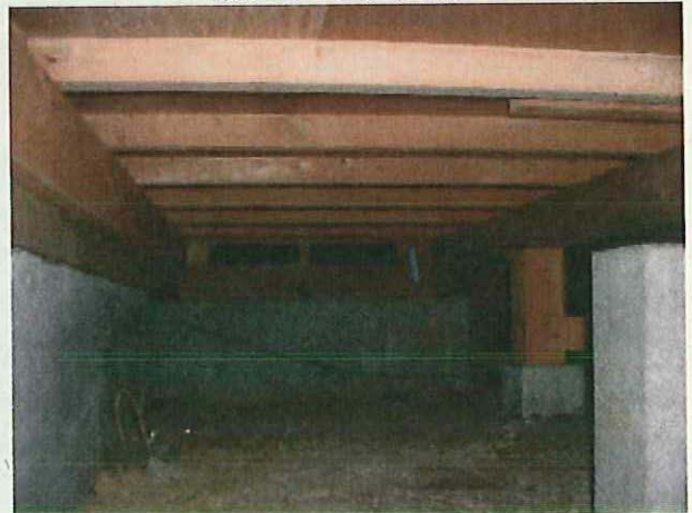
No.17 床下 基礎内側に異常は認められません。
