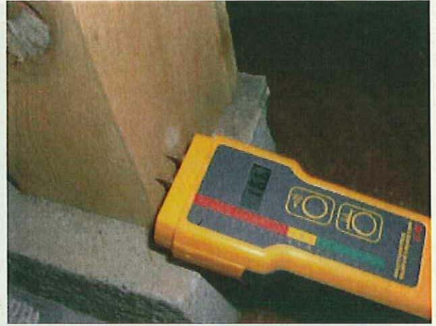
No.22 床下 木部含水率測定
