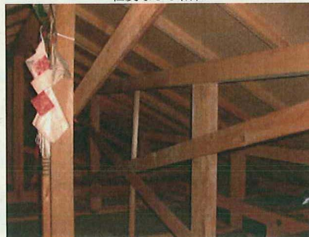
No.11 屋根裏 桁行き筋違い
