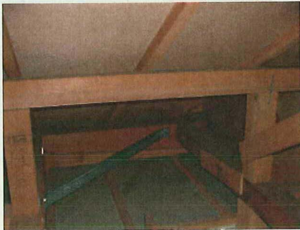
No.14 屋根裏 スチール製火打ち材 (ボルト止め)
