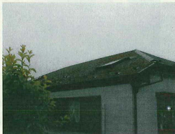
No.4 北西面屋根の一部
