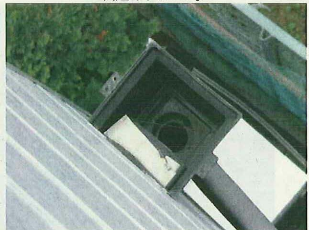
No.24 バルコニー排水柵 詰まり等の異常は認められません。
