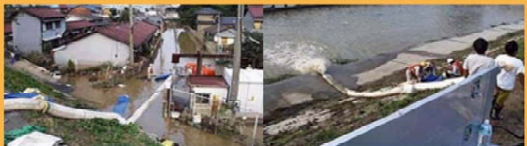
排水施設による排除状況
