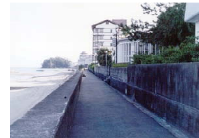
▲整備前の管理通路
