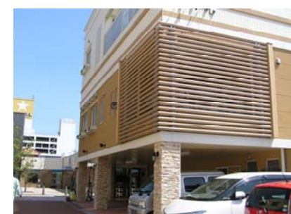
▲ファサードに木材を用いている建物
