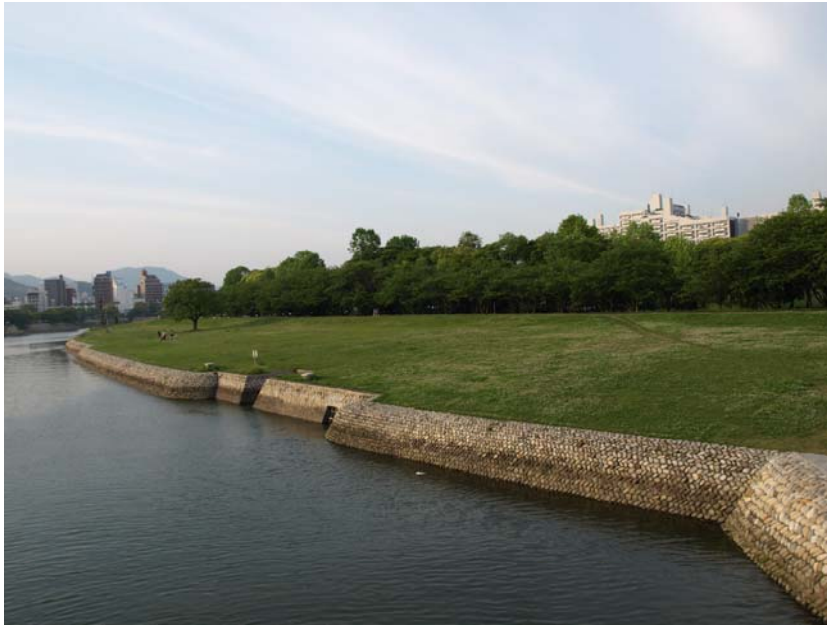
②直立に近い複断面の護岸部
