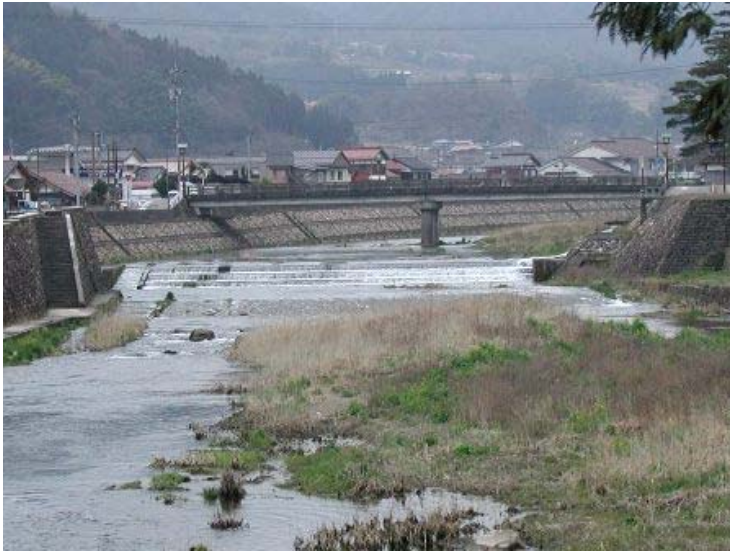
写真－落差工（左岸下流より）
