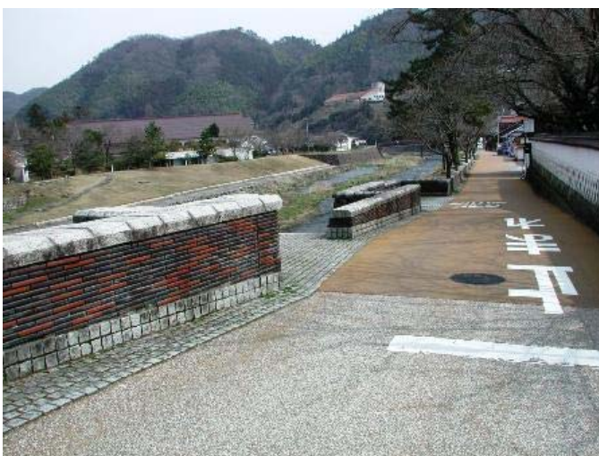
写真－石州瓦によるパラペットと笠石の設置
