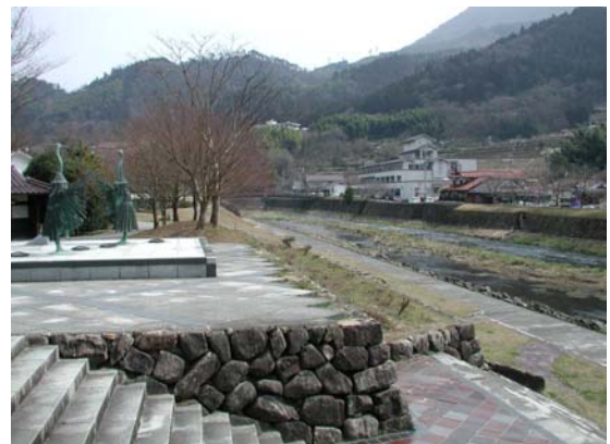
整備後の津和野大橋下流部
