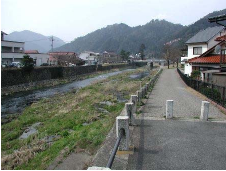
写真一川の自然な作用による河床の形成
