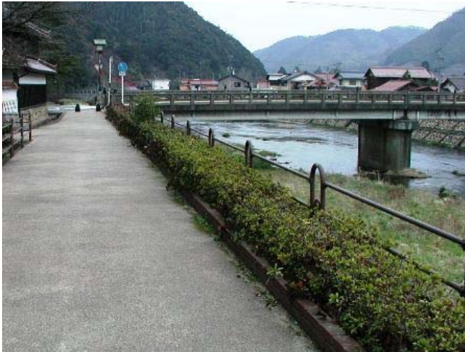
写真－護岸肩部への植栽の導入
