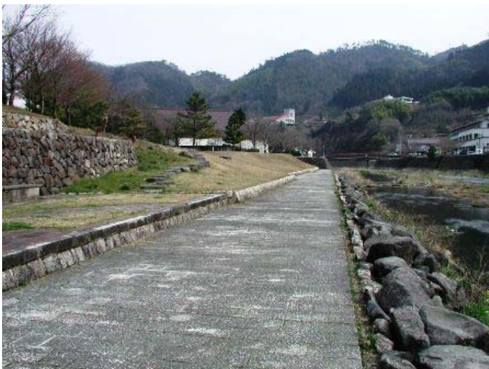
写真－庭園広場とテラスの連続性の確保
