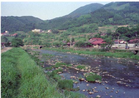
整備前の津和野大橋下流部 (昭和後期)
