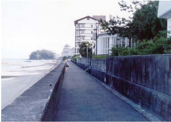
整備前の管理通路
