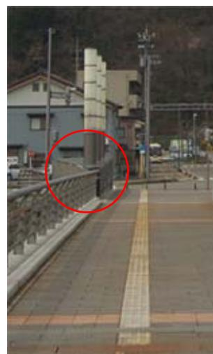
▲親柱は両端で幅の異なる歪な形状をしており、擦り付けの形を調整する役割を果たす
