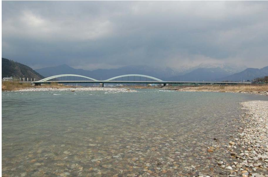
▲ライズを低く抑えた流水部の2連アーチと高水敷部の桁形式の橋梁形式
