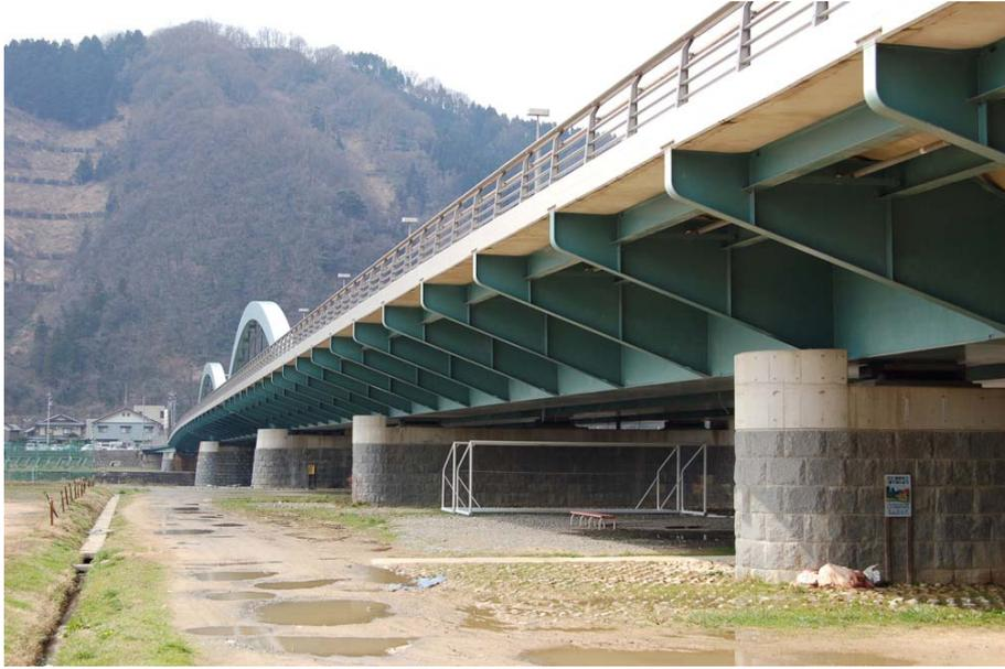
▲張り出し長の大きなブラケットと耳桁の処理
