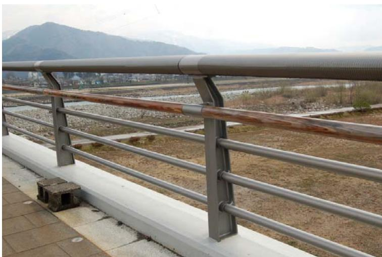
▲地場材の手摺りの傷みが激しく維持管理段階で変更された高欄手摺りの素材
