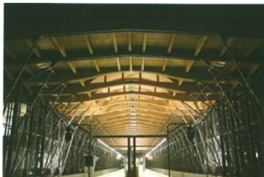
▲地元産材(杉)を用いた駅舎
