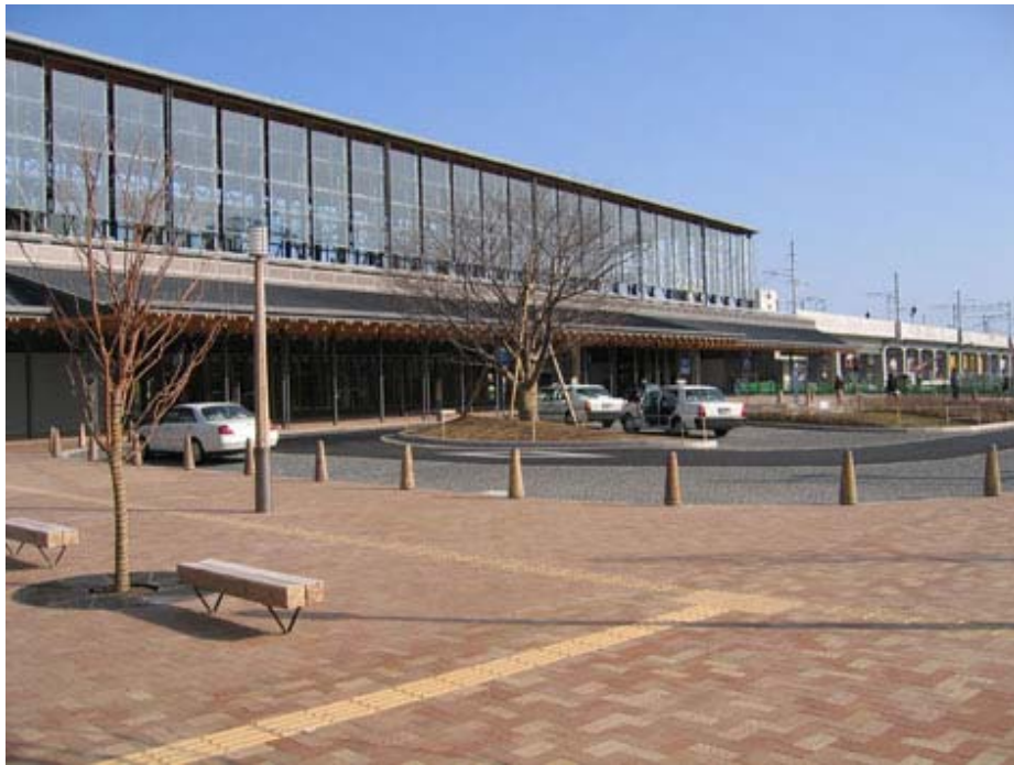
写真 トレインシェッドの駅舎と駅前広場
