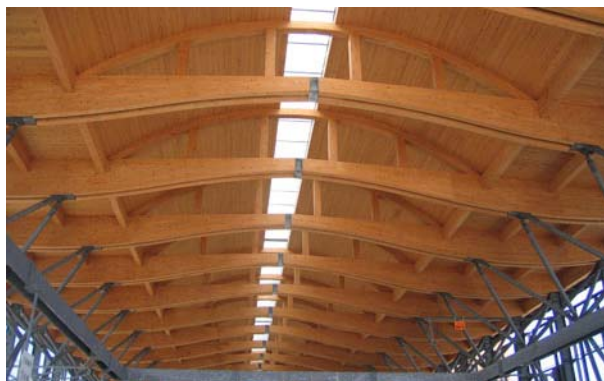
写真 駅舎の屋根架構に用いられた変断面集成材
