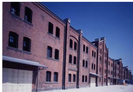
写－20 赤レンガ倉庫（市が保全活用） (建築年代：1913 年（1号倉庫）・1911 年（2号倉庫）、認定年度：2001 年)
