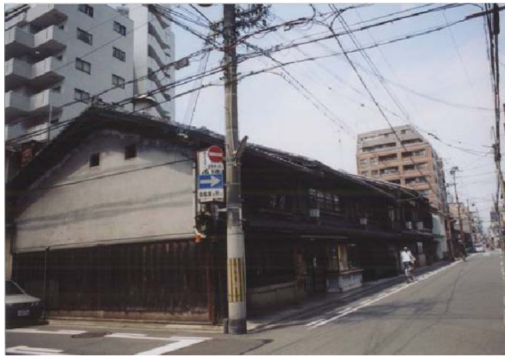
写－１０ 京都府京都市 消失した町家（解体前）
