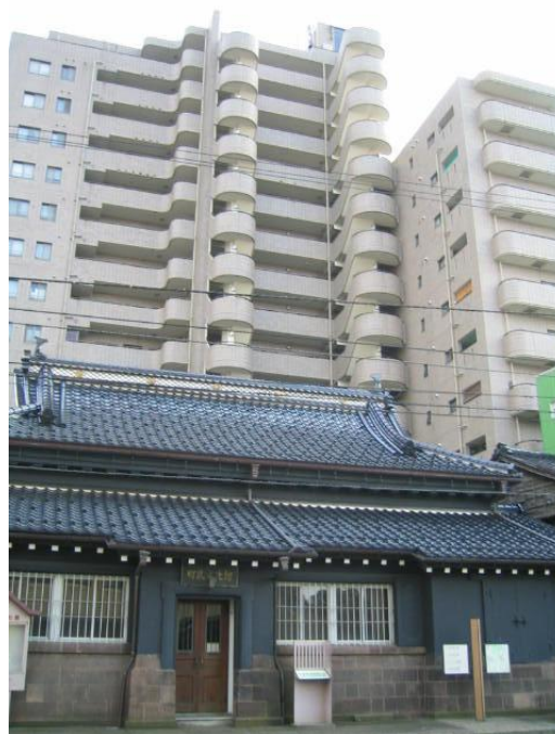
写－５ 石川県金沢市 県指定文化財の背後に建設された高層マンション
