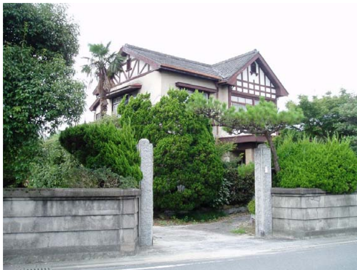
写－１６ 福岡県太宰府市 解体された昭和初期の蚕会所
