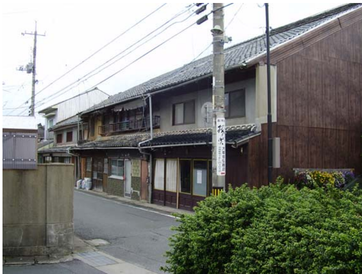
写－12 山口県萩市 解体された伝統的建造物群保存地区内の伝統的建造物
