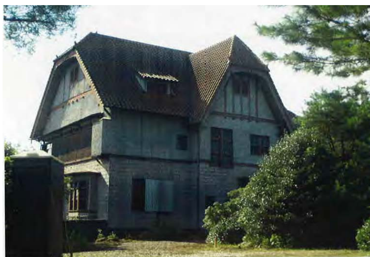
写－１７ 大分県別府市 解体された山中別荘
