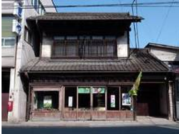
写－２ 山形県山形市 平成18年に解体された繁田園茶舗
