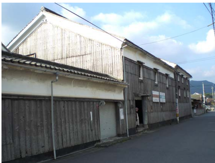
写－13 山口県萩市 解体された有形登録文化財の候補物件（病院別館）
