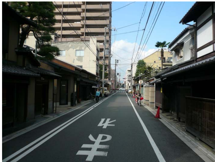
写－１１ 京都府京都市 高層マンションに建替えられた町家
