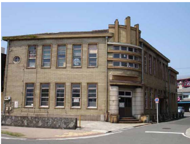
写－１４ 福岡県北九州市 解体された旧麻生商店若松支店(旧麻生鉱業ビル)
