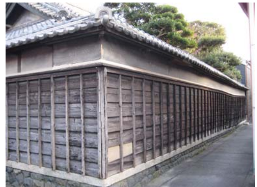
棚田地区における庄屋の外壁
