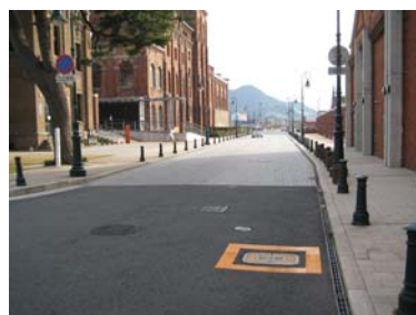
右の倉庫棟にあわせて幅員を絞っている。
