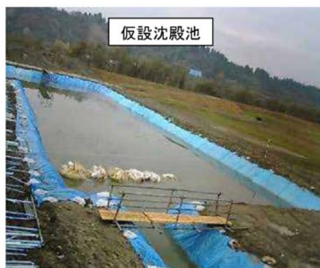
写真-2 仮設沈殿池の設置状況
