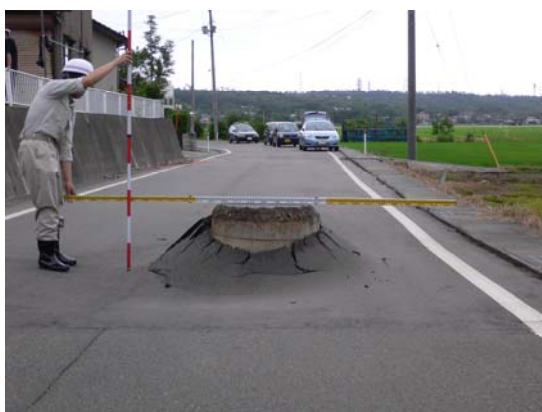
写真-4 マンホールの突出状況
