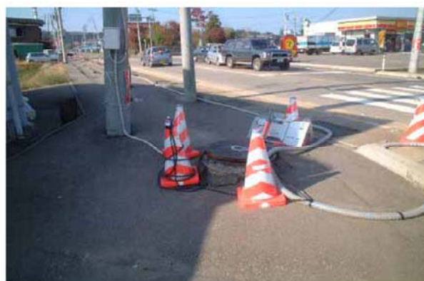
写真-3 仮配管・仮排水ポンプによる応急復旧状況
