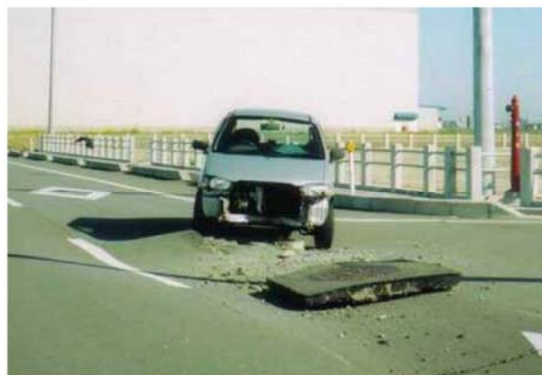
写真-5 突出したマンホールに激突した車輛
