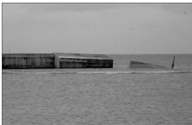
●島根県釜港防波堤の被災(冬期風浪)
