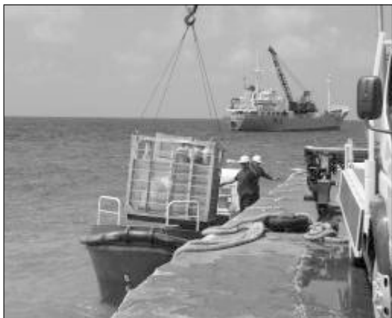
大型岸壁がないため小型船に積みかえて陸上げをしている様子
