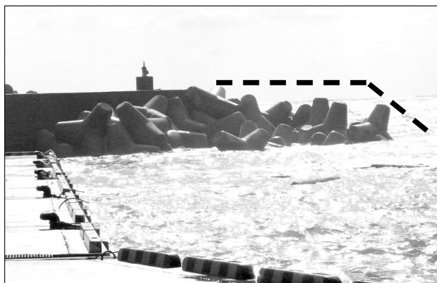
●島根県釜港防波堤の被災(冬期風浪)
