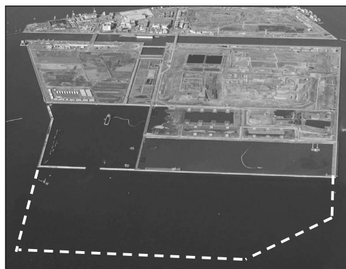
【東京港 海面処分場】
