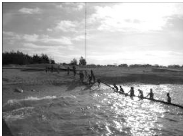
係留施設がないため人力でパイプラインを接続している様子
