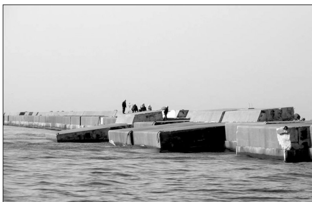
●新潟県新潟港臨港道路(トンネル)の被災(冬期風浪)
