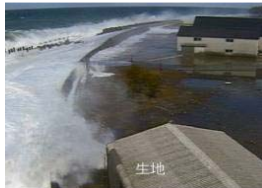
越波の状況(富山県黒部市生地地区)
