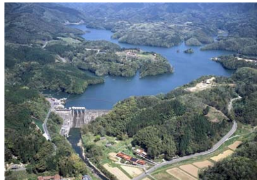
<木屋川ダム現況写真>
