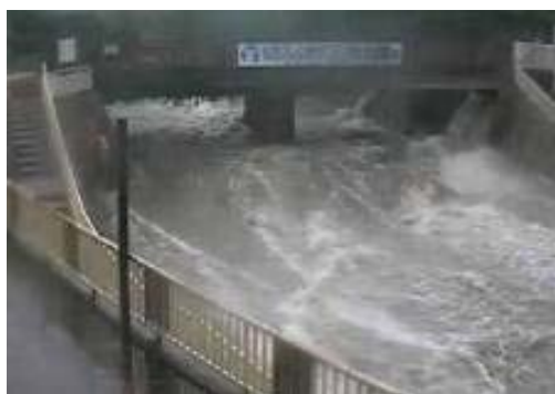
都賀川の出水状況
