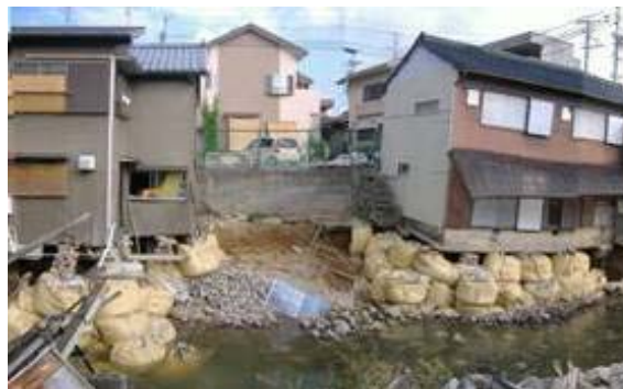
伊賀川の被災状況(愛知県岡崎市)
