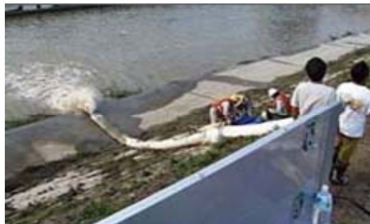
排水施設による排除状況
