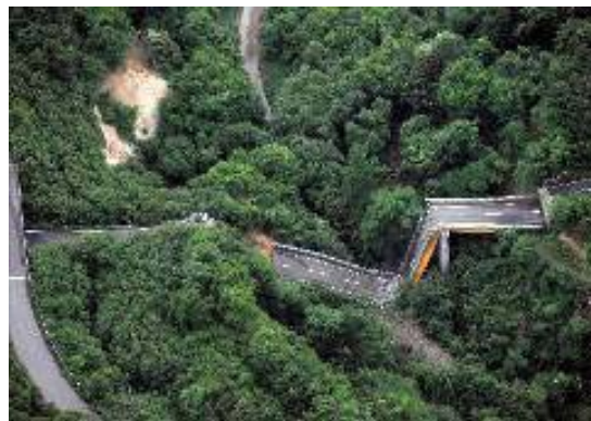
祭時大橋（岩手県一関市）
