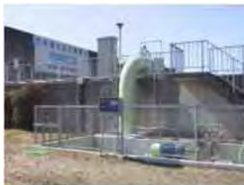
小水力発電の設置例
