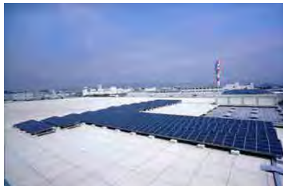
大阪府安威川流域下水道中央水みらいセンターに導入された太陽光発電施設(300kW) 高度処理施設などに使用 (写真：大阪府 HP)
