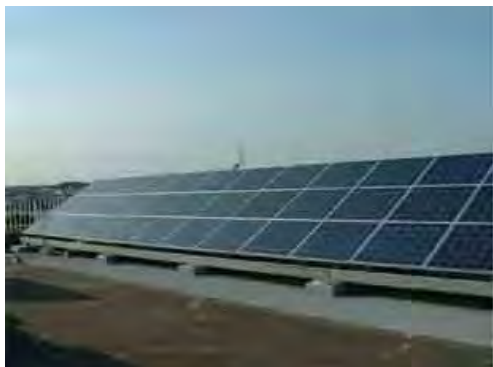
愛知県衣浦西部浄化センターに導入された太陽光発電施設(30kW) 管理本館の空調整備、照明などに使用 (写真：愛知県 HP)
