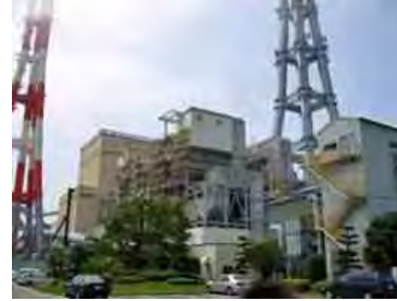
常磐共同火力発電所発電施設
