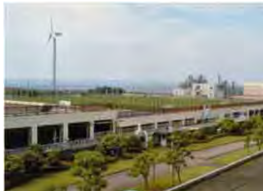
静岡市中島大須賀浄化センターに導入された風力発電施設(定格出力 1,500kW) (写真：静岡市 HP)
