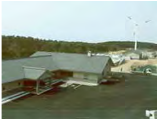
静岡県掛川市大須賀浄化センターに導入された風力発電施設(定格出力 660kW) (写真：国土交通省都市・地域整備局下水道部 HP)
