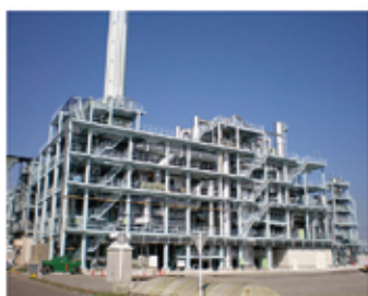
汚泥炭化施設
